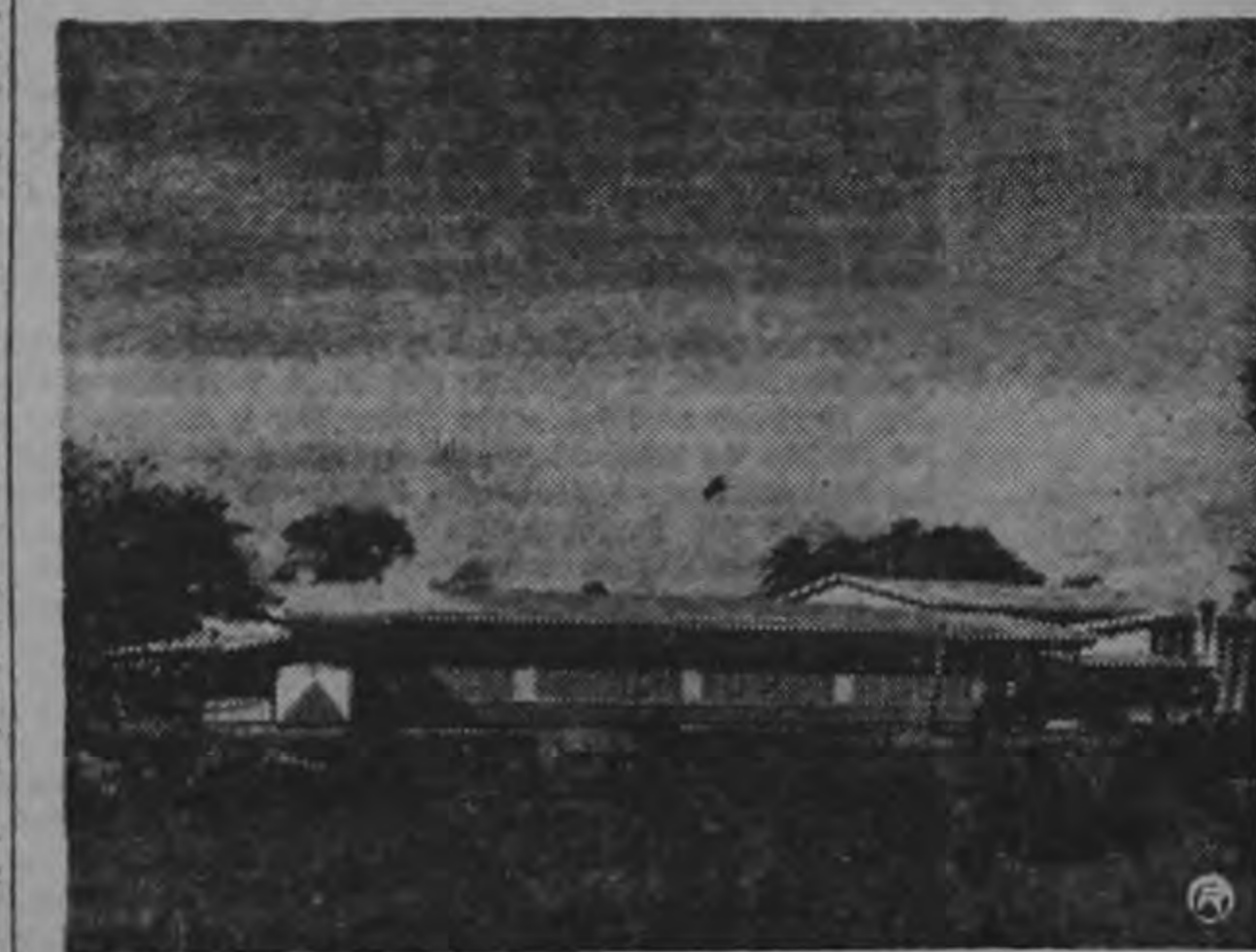
CONJUNTO DEL LOCAL ESCOLAR
